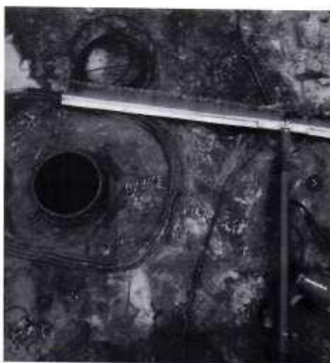
图 4-1 防渗膜修补及复测
