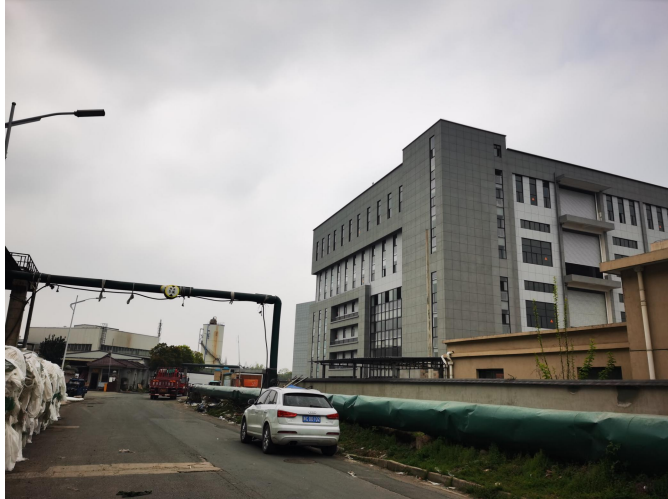
西侧（安吉龙鑫印染有限公司在建厂房）
